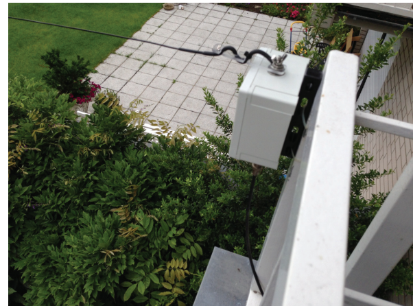
Transformator befestigt am Balkongeländer (ungünstig), fehlender Abstand zum Eisen (Masse)
